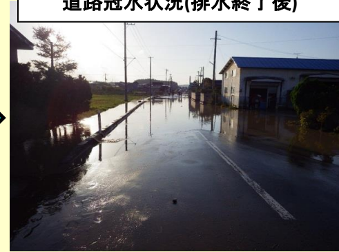
道路冠水状況(排水終了後)
