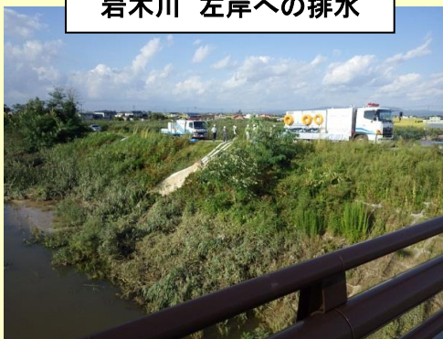
岩木川 左岸への排水
