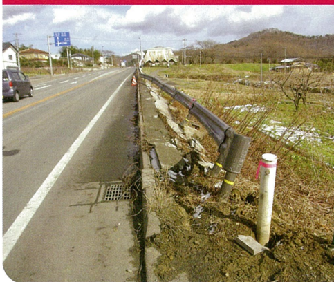
ガードレール・標識等の損傷
