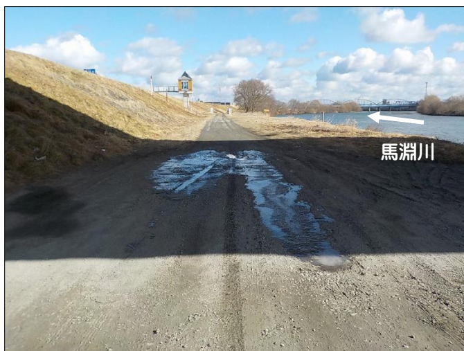
左岸4.0km付近 【補修前】
