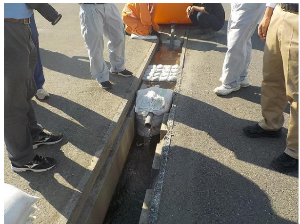
▲ 側溝での土のう積工法
