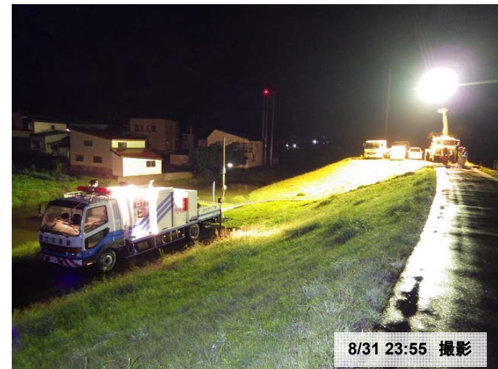
排水ポンプ車・照明車活動状況
