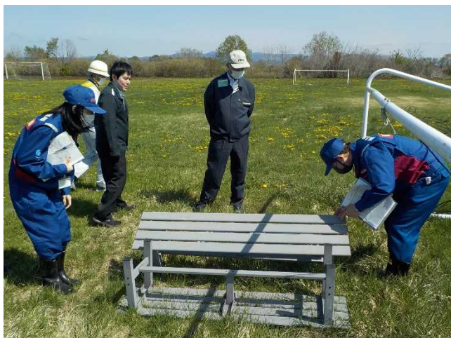
点検状況(稲垣河川公園)
