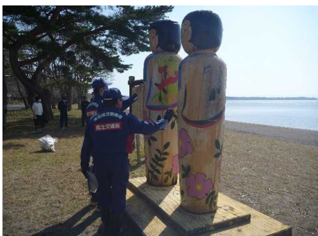
点検状況(三沢湖水浴場)
