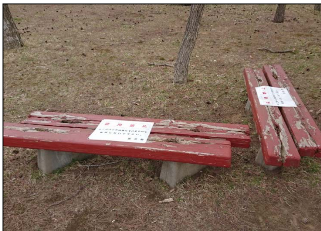
使用禁止の注意喚起を行いました。（4月23日措置完了）
