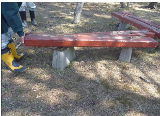
ベンチのボルトが腐食し外れていました。
