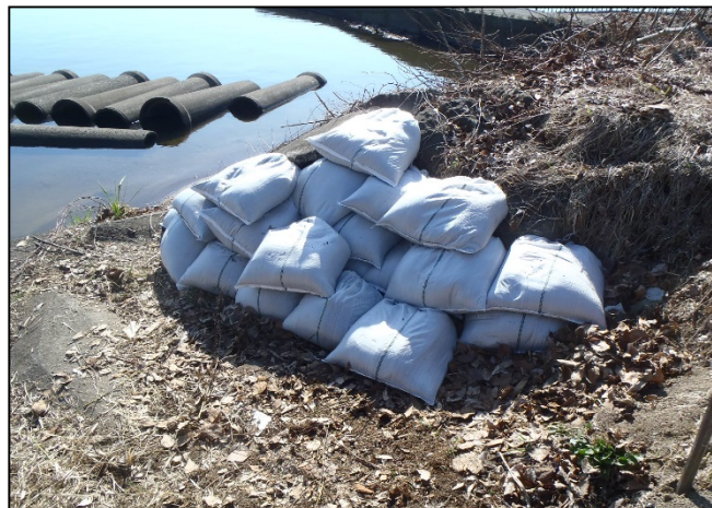
土のうにて応急復旧を行いました。（4月20日措置完了）
