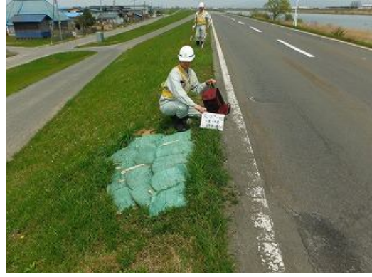
▲堤防法肩の補修状況
