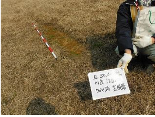
▲法面踏み荒らし(タイヤ跡)
