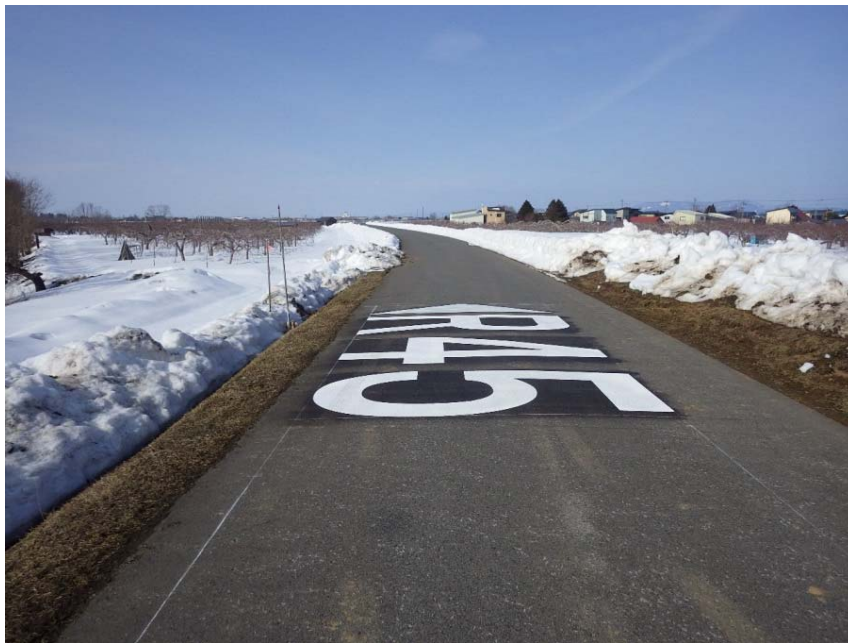
岩木川右岸（板柳町）
