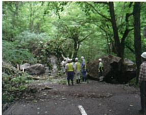
H20.7.24発生 落石・崩落 (地震)
