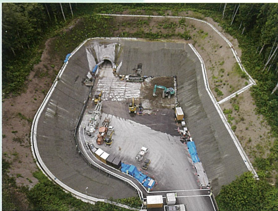
トンネル起点側
