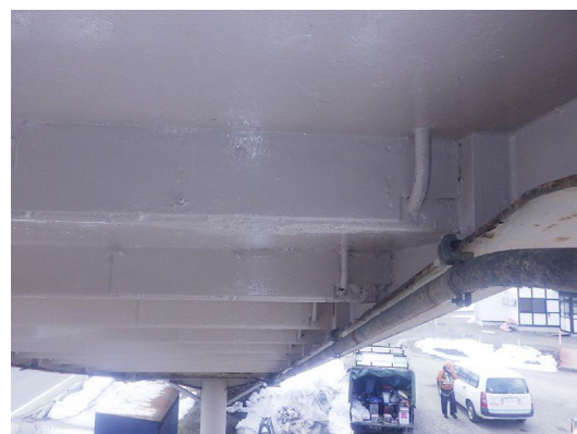
【対策】床版変形補修
