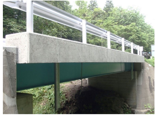
【全景】奥薬研12号橋
