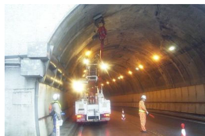
写真2-2 トンネル点検状況
