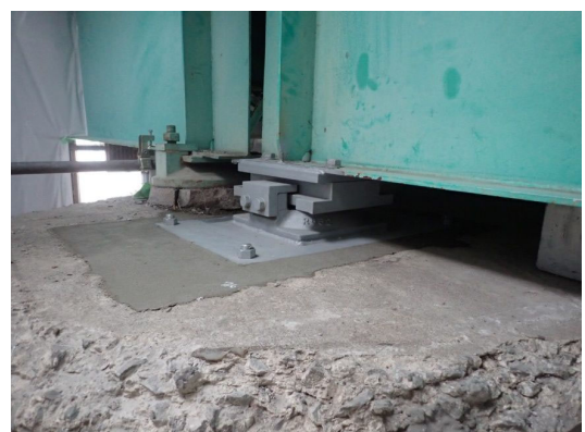
【対策】支承取替
