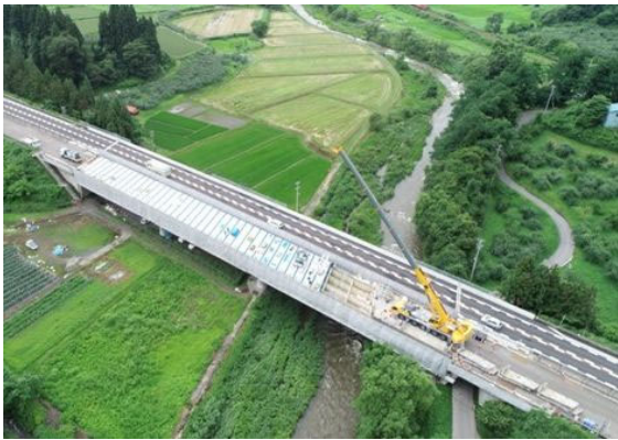
床版取替状況
