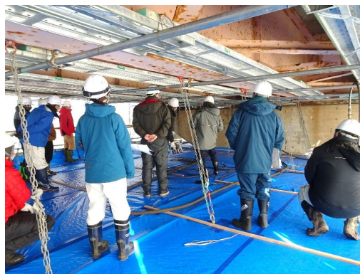
橋梁補修施工管理研修状況
