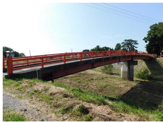
【全景】八幡宮橋
