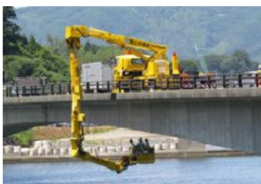
写真2-1 橋梁点検状況
