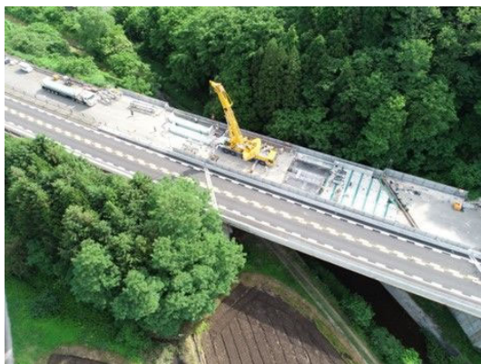
床版取替状況
