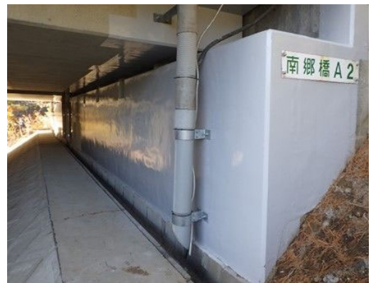
【対策】断面修復
