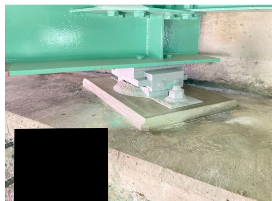
【対策】支承防錆（金属溶射）
