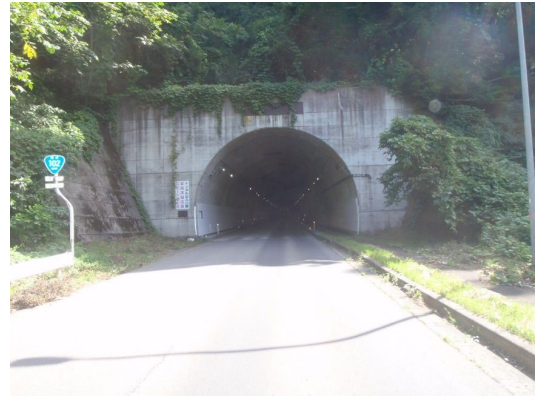
【全景】板留トンネル
