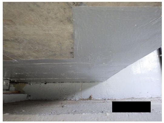
【対策】断面修復及び表面保護工
