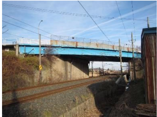
写真4-4 【全景】山口跨線橋
