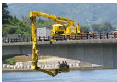
写真2-1 橋梁点検状況
