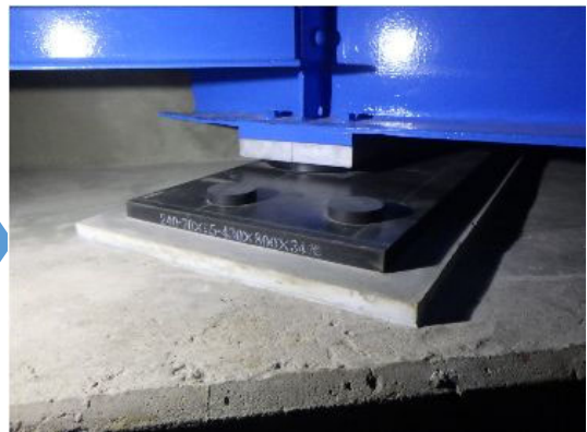
写真4-6 【対策】 支承交換、沓座モルタル打換
