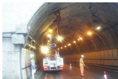
写真2-2 トンネル点検状況
