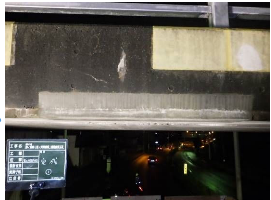
写真4-15 【対策】断面修復
