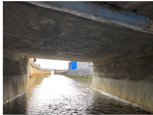
写真 4-9 【対策】断面修復
