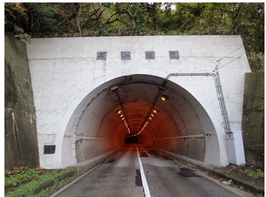
写真4-16 【全景】森山トンネル
