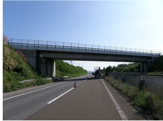
写真4-1 【全景】町屋敷橋
