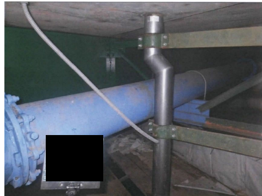
写真 4-12 【対策】排水管取替
