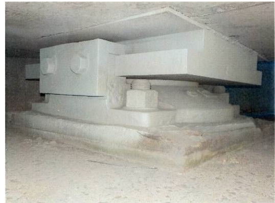
写真4-3 【対策】支承防錆(金属溶射)
