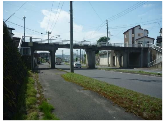
写真4-13 【全景】西ノ沢跨道橋
