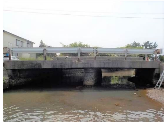
写真 4-7 【全景】瀬戸子橋
