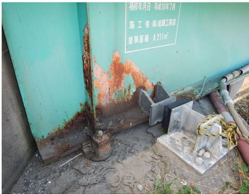
写真4-22 主桁端部の腐食事例
