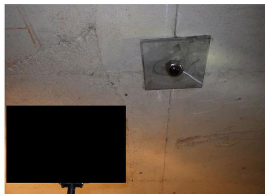
写真4-18 【対策】ロックボルト補修
