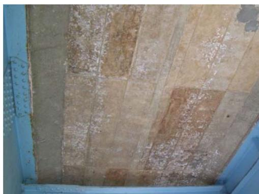
写真4-5 【損傷】床版の遊離石灰
