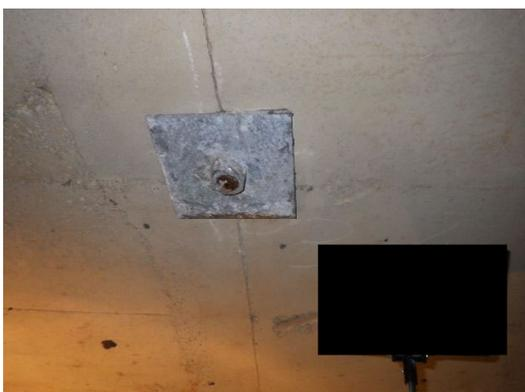
写真4-17 【損傷】ロックボルト腐食
