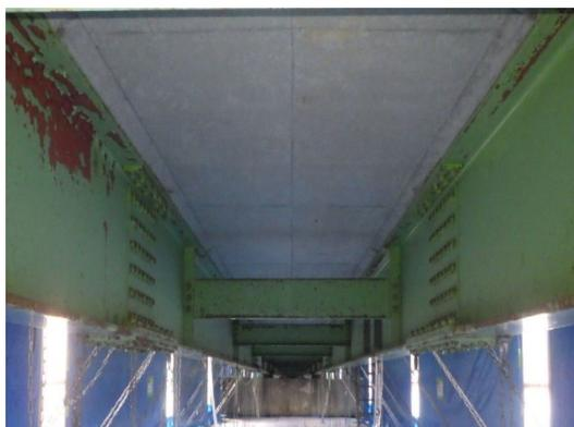
写真4-2 【損傷】主桁腐食
