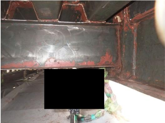
写真4-20 【損傷】横桁の変形
