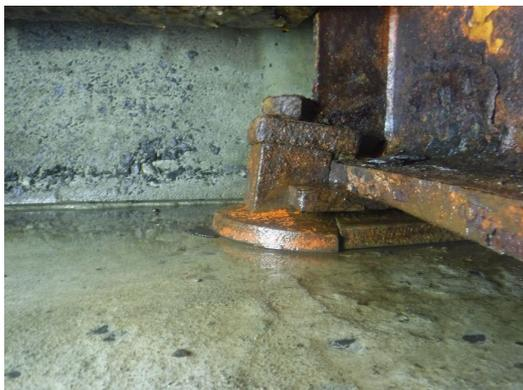
写真4-11 【損傷】支承の破損
