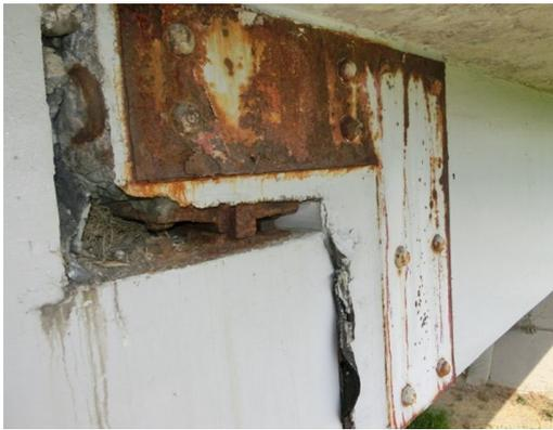
写真4-8 【損傷】主桁、支承部の腐食
