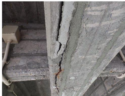
写真4-23 鉄筋の腐食によるひびわれ、うき
