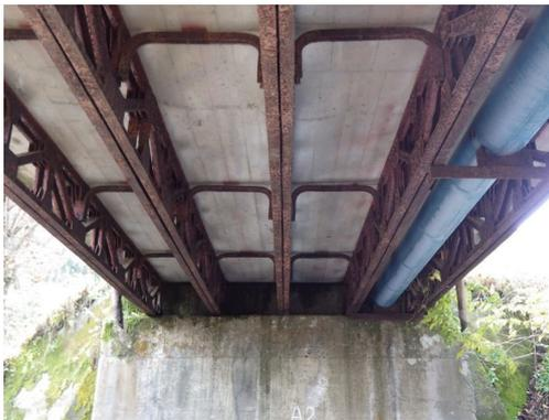
写真4-14 【損傷】主桁の腐食
