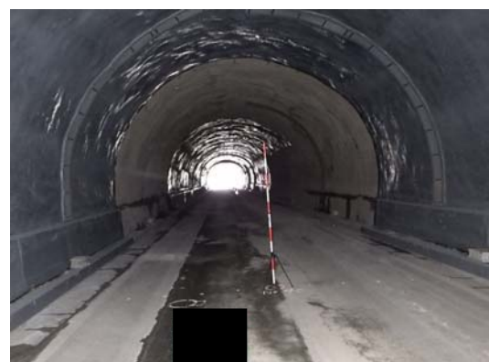
写真4-18 【対策】トンネル剥落防止工
