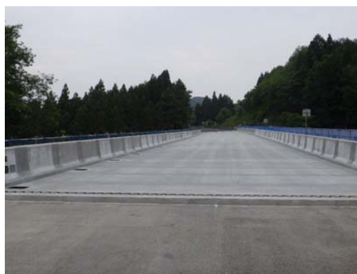
写真4-9 【対策】床版取替
