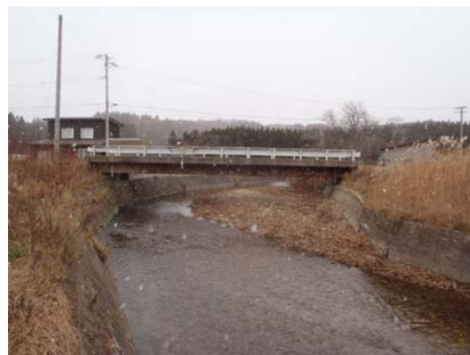
写真4-1 【全景】第2太田橋
