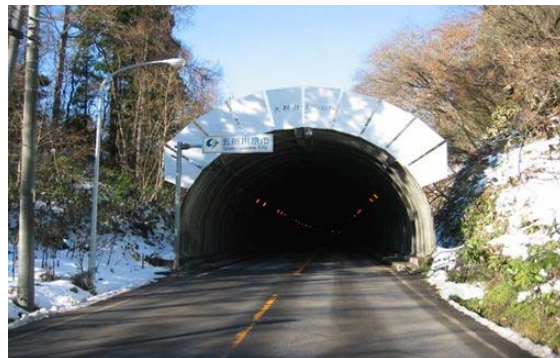
写真4-19 【全景】 大釈迦スノーシェルター
