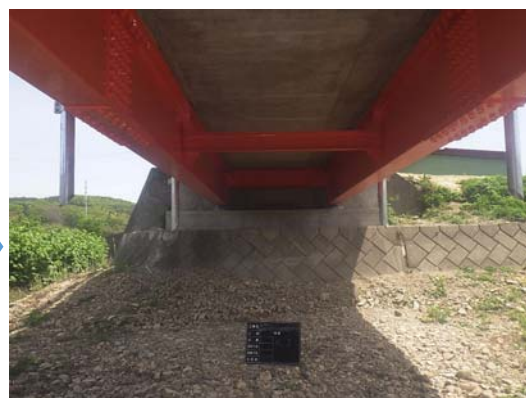
写真4-3 【対策】桁材の塗装塗替
