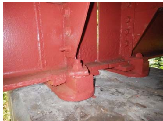
写真4-15 【対策】支承防錆
