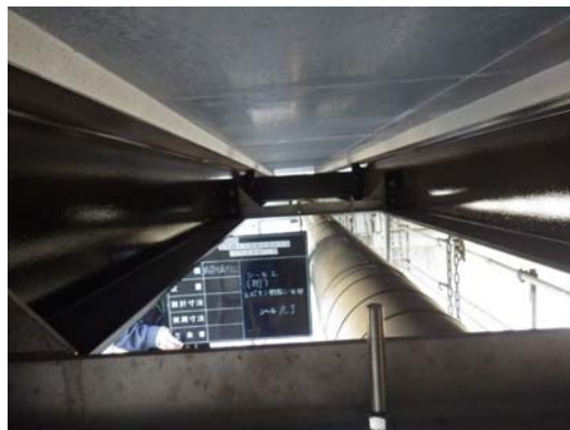
写真4-12 【対策】床版取替
