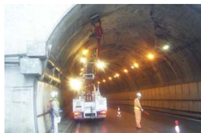
写真2-2 トンネル点検状況
