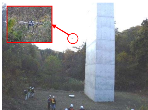
写真5-3 現場研修状況 (UAVによる近接目視点検)
