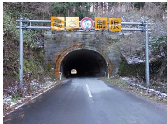
写真4-16 【全景】手倉橋隧道
