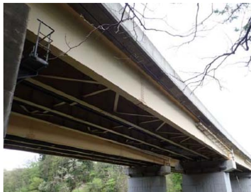
写真4-7 【全景】梨子野木橋
