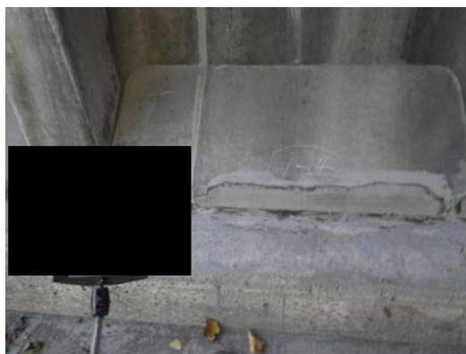
写真4-21 【対策】断面修復
