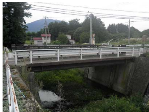
写真4-10 【全景】貝沢橋側道橋
