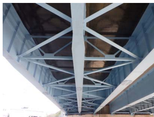
写真4-4 【全景】床版下面状況
