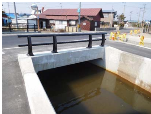
写真4-12 【対策】架替(BOX化)
