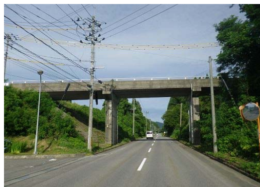
写真4-1 【全景】第三長川水源池橋
