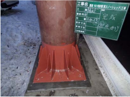
写真4-18 【対策】 スノーシェッド支承の補強
