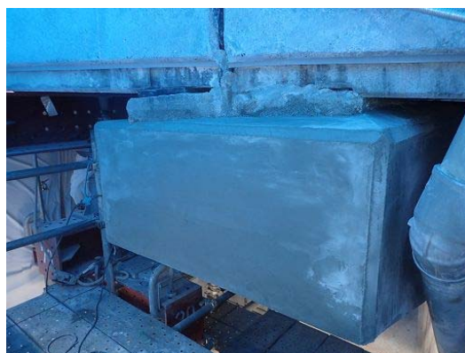
写真4-3 【対策】断面修復による補修
