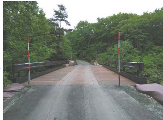
写真4-21 【応急対策】仮橋設置
