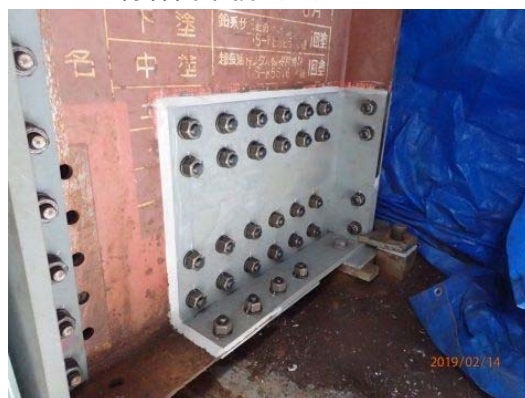
写真4-9 【対策】あて板補修
