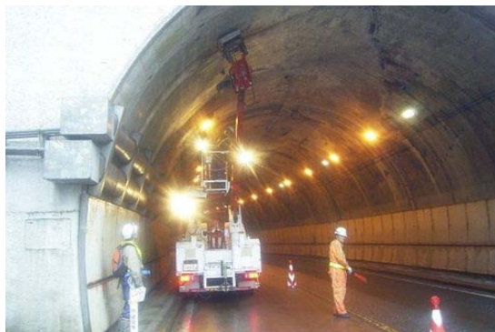
写真3-2 トンネル点検状況
