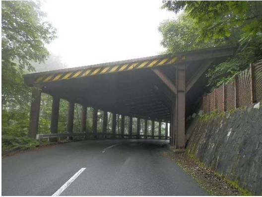
写真4-16 【全景】鳶スノーシェッド
