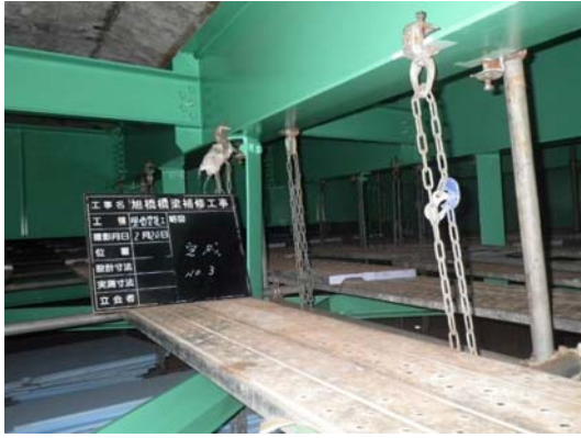
写真4-15 【対策】 鋼橋の桁材等の塗替え
