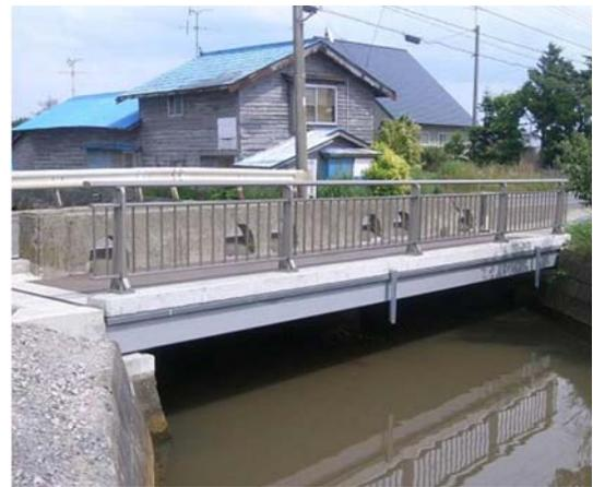
写真4-21 【対策】上部工架替
