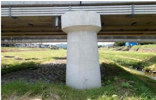
写真4-9 【対策】断面補修
