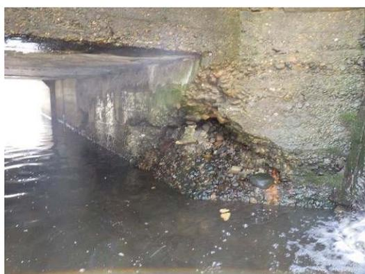
写真4-5 【損傷】橋台の断面欠損
