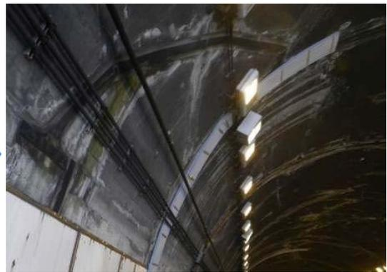
写真4-15 【対策】導水工の設置
