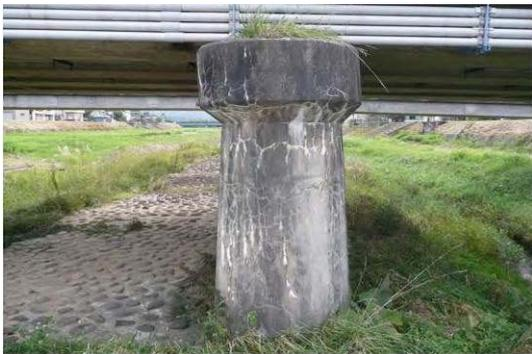
写真4-8 【損傷】下部工のひびわれ
