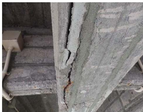
写真3-4 鉄筋の腐食によるひびわれ、うき
