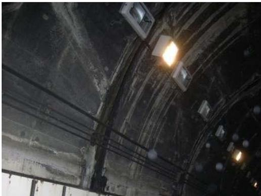
写真4-14 【損傷】漏水
