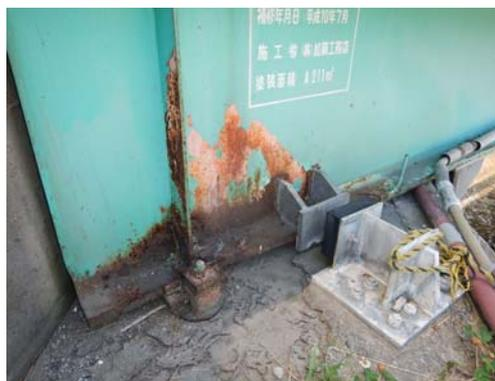
写真3-3 主桁端部の腐食事例
