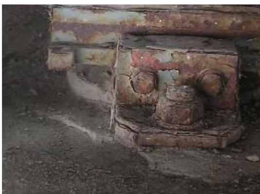
写真4-2 【損傷】支承本体の腐食
