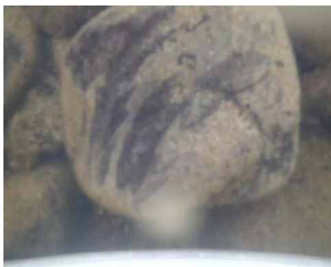
産卵が確認できないがハミ跡を確認 (新鳴瀬橋)
