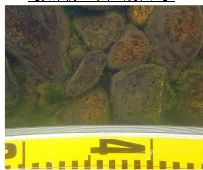
【安東橋の河床（現況）】
