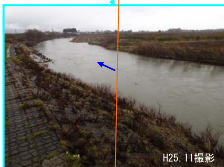
※平常時の流速が低下する箇所で、土砂が堆積するため、瀬が形成されやすい。現地では、白波が立つ状況となっている。
