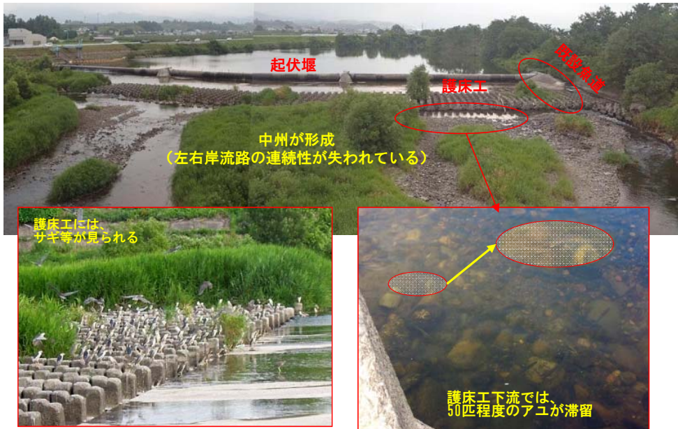
湯水時の取水堰下流の状況：H23.8.3
