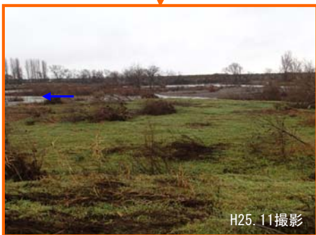
※H5河道では、平常時の流速が低下する箇所で、土砂が堆積し砂州が形成されやすい、近年は砂州上の樹林化が進行していた。台風18号後に、砂州上の樹木がフラッシュし砂州地形が現れ、河道内の環境が変化している。
