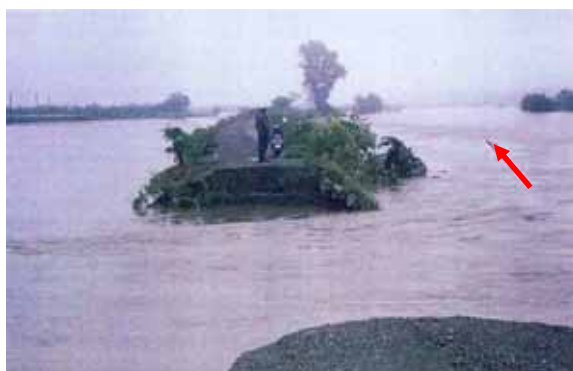
平成 2 年 9 月洪水 三戸郡南部町虎渡地区 左岸堤防の決壊状況
