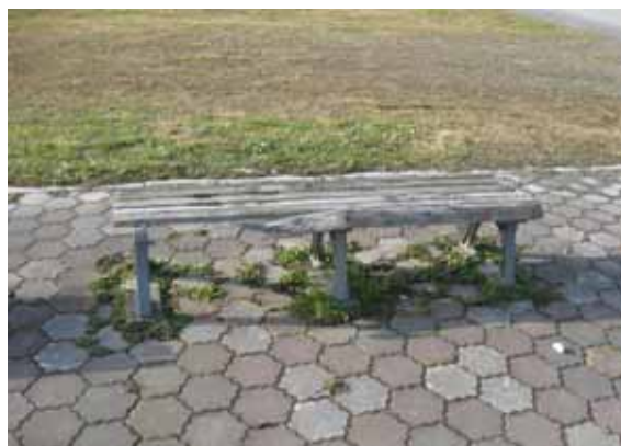
「安全利用点検」で確認されたベンチの損傷
