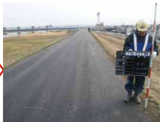
堤防天端の舗装（舗装後）
