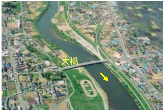
市街地を流れ、広い高水敷が整備されている
