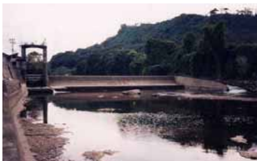
舌崎発電所 取水堰下流地点（改善前）
