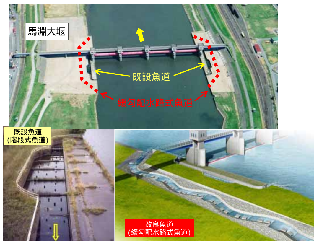
図 5.13 馬淵大堰の魚道の改良イメージ
