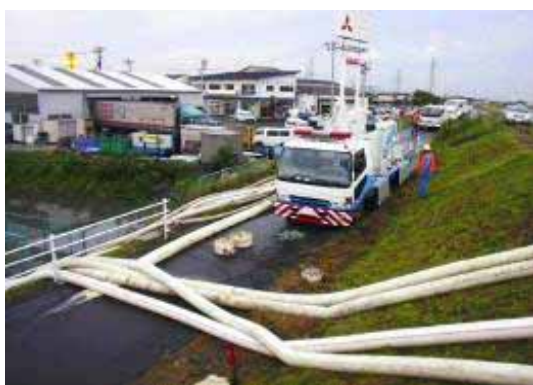
長苗代地区第二排水樋管の内水排除状況
