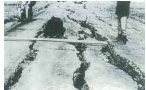
十勝沖地震による馬淵川堤防天端の亀裂
