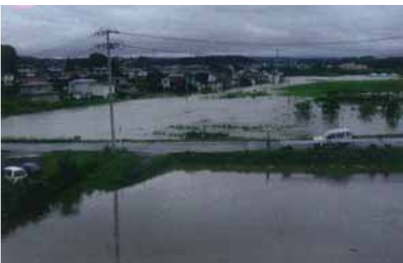
平成 14 年 7 月洪水 八戸市大川原地区の浸水状況
