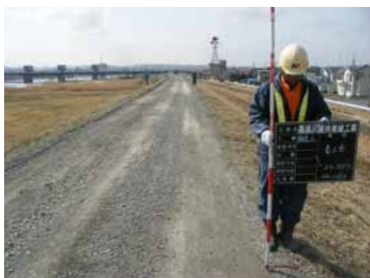
堤防天端の舗装（舗装前）
