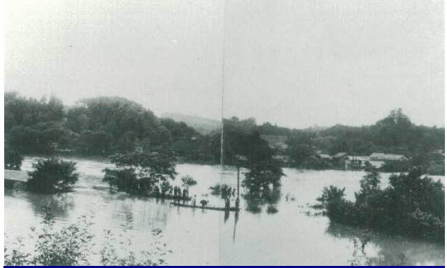
昭和 15 年（1940 年）9 月洪水 櫛引橋付近の様子
