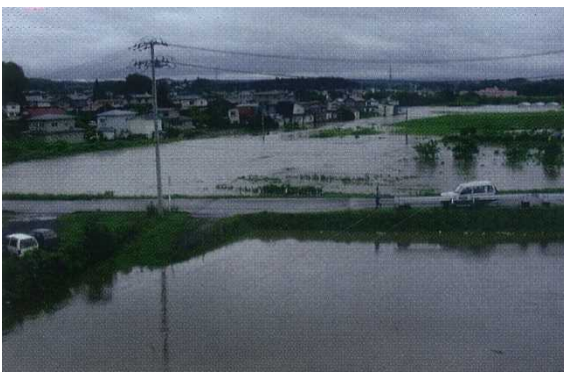
平成 14 年（2002 年）7 月洪水 八戸市大川原地区の浸水状況
