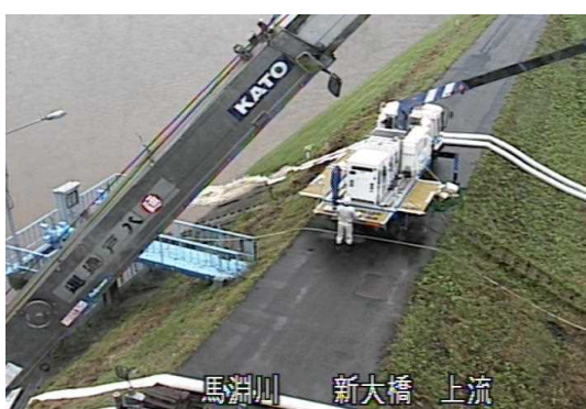
八戸市所有の排水ポンプ車による内水排除状況
