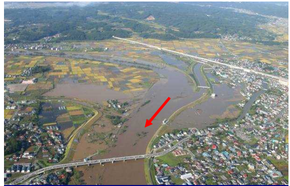
平成 16 年（2004 年）9 月洪水 八戸市八幡・尻内地区の浸水状況
