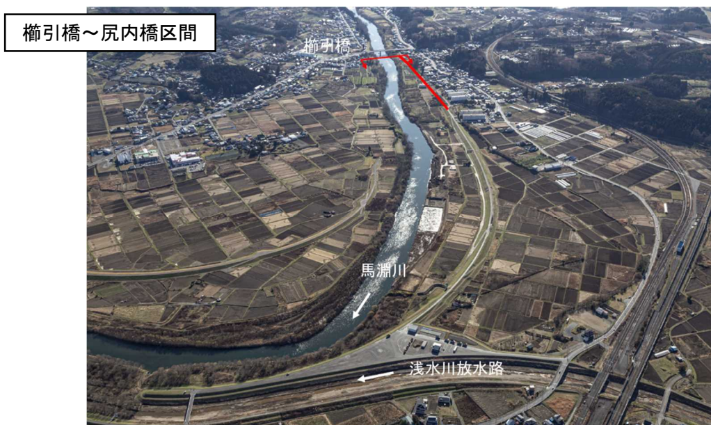
図 5.3 堤防の量的整備箇所（令和 5 年（2023 年）3 月時点）
