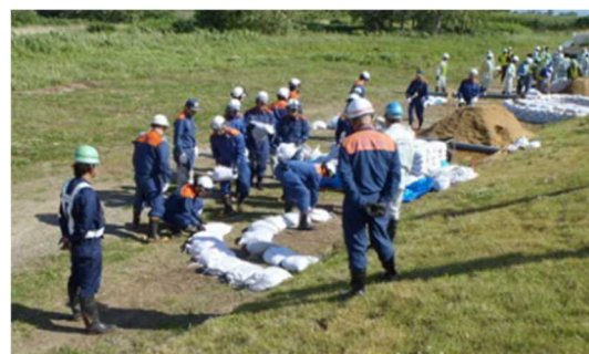
水防技術協議会 水防工法実施状況
