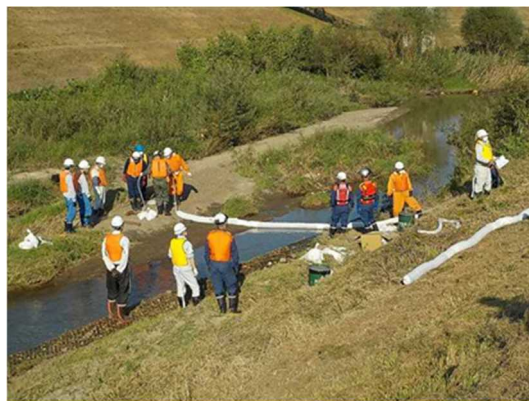
オイルフェンス設置訓練の様子
