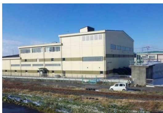
下長雨水ポンプ場（管理者：八戸市）
