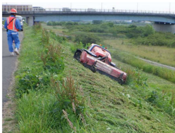
こまめな堤防除草によるアレチウリ等外来種拡大防止
