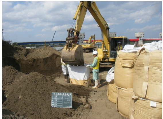
発生土砂は仮設工事の土嚢に利用 (土嚢の作成)
