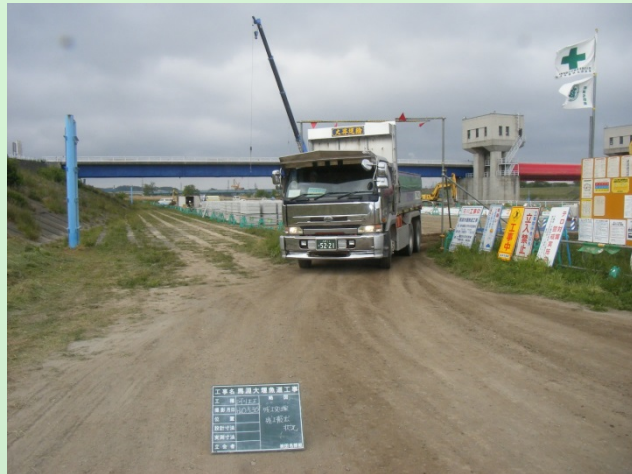
発生土砂は新設堤防の盛土材料に利用 (土砂の搬出)
