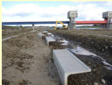
堆積土砂撤去中 H23. 11. 21撮影
