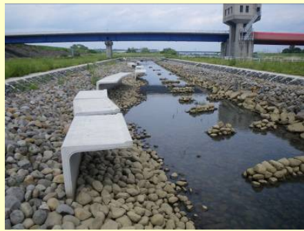
H22改良工事後の状況
