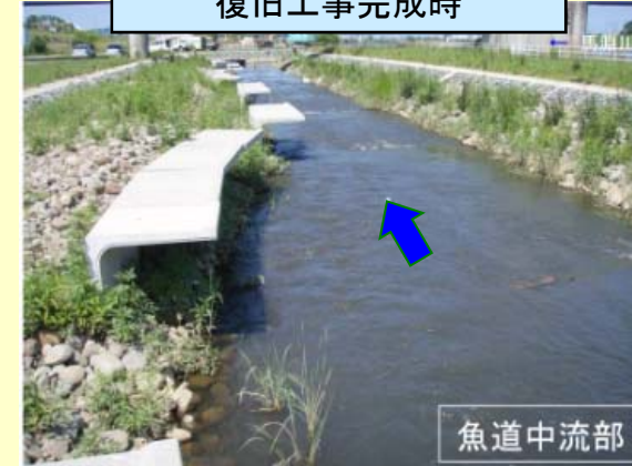
復旧工事完成時
