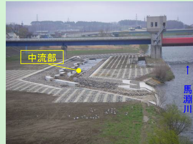
馬淵大堰左岸新設魚道(せせらぎ式魚道)
