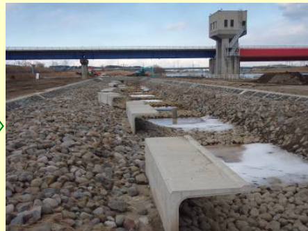
河床部復旧作業中 H24. 1. 10撮影
