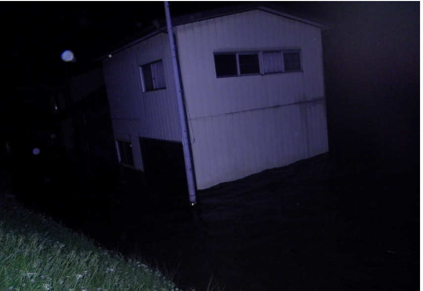
南部町大向地区 (床上浸水)
