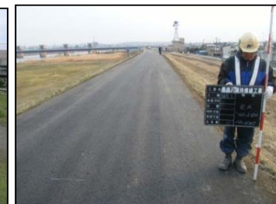
舗装後の状況
