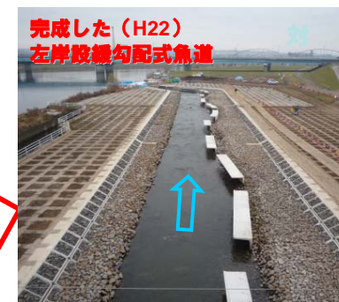
緩勾配式魚道に改築することにより、遡上環境を向上
