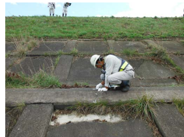
護岸の損傷状況
