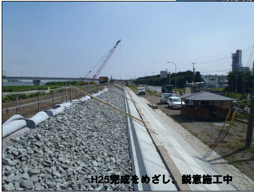
堤防強化対策は、2tブロックにより堤防全面を被覆する構造
