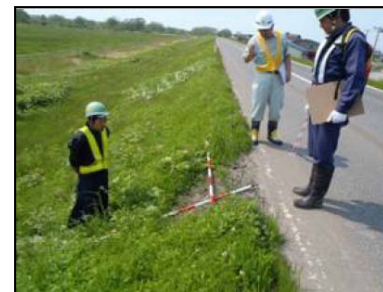
堤防の目視点検状況
