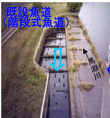
既設魚道の機能が十分でないため魚の遡上阻害 (昭和 55 年 3 月完成)
