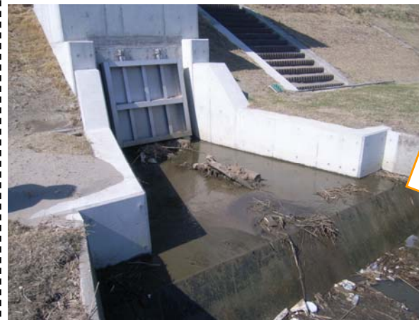
予備ゲートの整備
