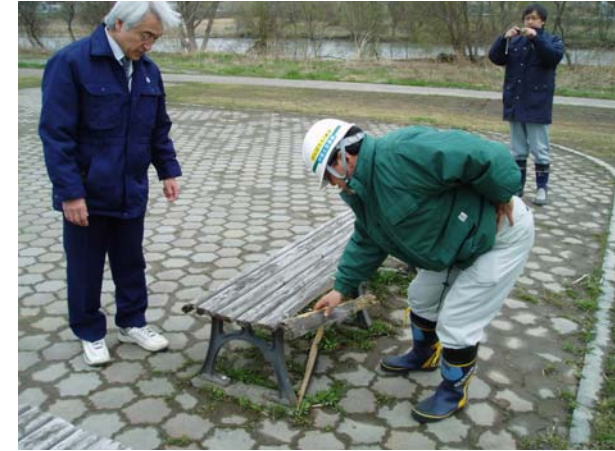
安全利用点検の様子
