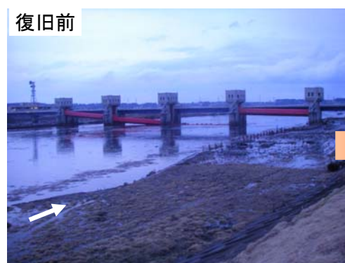
②【左右岸2.6k付近】馬淵大堰戸当り4門変形・ワイヤー固定金具破損
