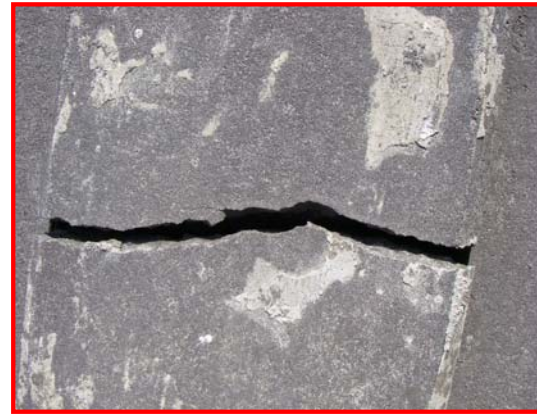
護岸の損傷状況
