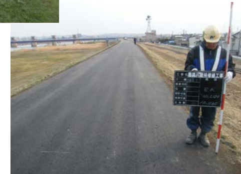
舗装後の状況
