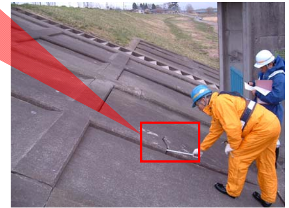
護岸の損傷状況
