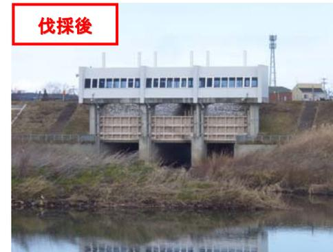
樹木の繁茂により、洪水流下阻害が生じ、またCCTVカメラによる排水樋門の開閉状況が確認出来ない状況
