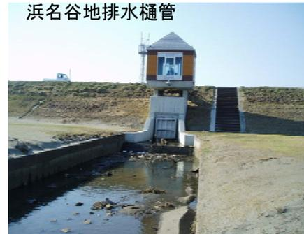
予備ゲート整備済である「浜名谷地排水樋管」及び「中河原排水樋管」では本震災の津波による逆流被害は発生していないことから十分な効果を発揮した。
