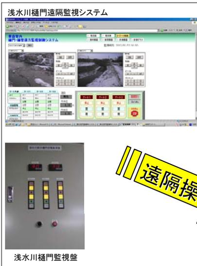
浅水川樋門は、八戸出張所での遠隔操作により、ゲートの開閉を行っている
