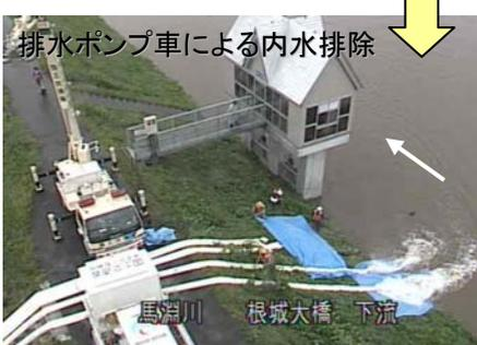
馬淵川左岸(尻内河原地区の長苗代第二排水樋管、下河原地区の浅水川排水樋門、大川原地区)において、内水および外水被害を軽減させるため、青森河川国道事務所では、排水ポンプ車を出動し対応を行った。
