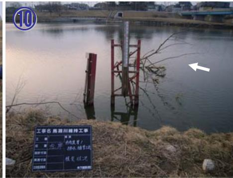
【左岸4.0k付近】水位計変形
