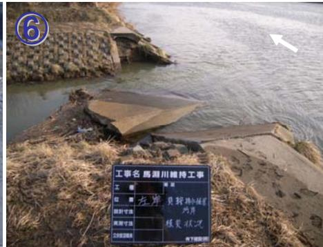
【左岸2.4k付近】樋管堤外水路破損
