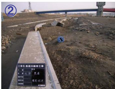
【左岸2.6k付近】土砂堆積による魚道の閉塞
