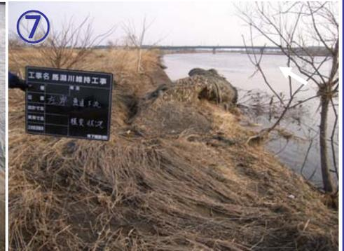
【左岸2.5k付近】護岸(かごマット)破損
