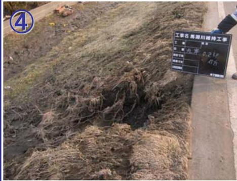
【左岸0.2k付近】堤防川表法面損傷
