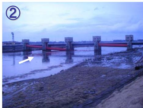
【左右岸2.6k付近】馬淵大堰戸当り4門変形・ワイヤー固定金具破損
