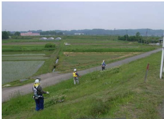
▲ 堤防除草作業の様子
