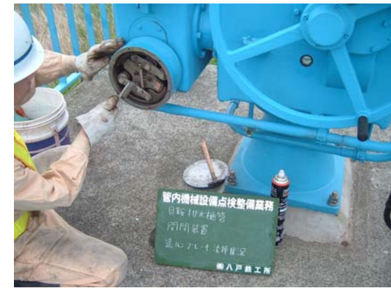
▲ 樋門・樋管点検の様子
