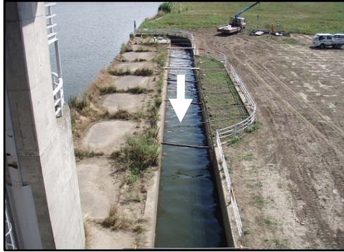
既設の階段式魚道
