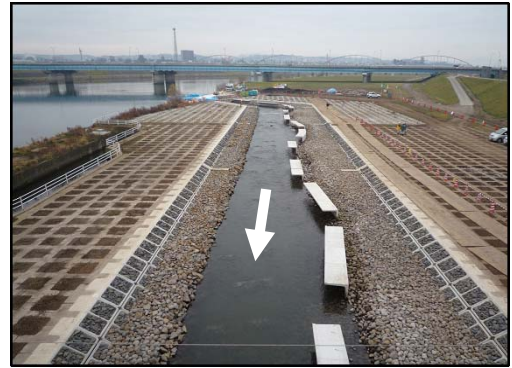
せせらぎ(緩勾配式)魚道
