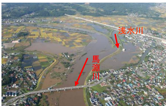
浅水川合流点付近の浸水状況
