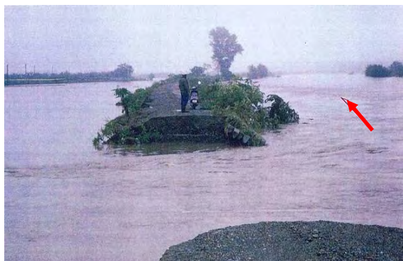
平成 2 年 9 月洪水 三戸郡南部町門前虎渡地区 左岸堤防の決壊状況
