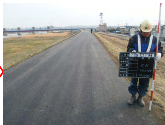
堤防天端の舗装（舗装後）
