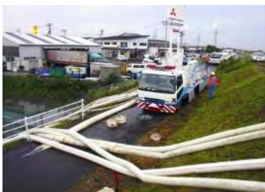
長苗代地区第二排水樋管の内水排除状況
