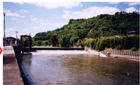
舌崎発電所 取水堰下流地点（改善後）
