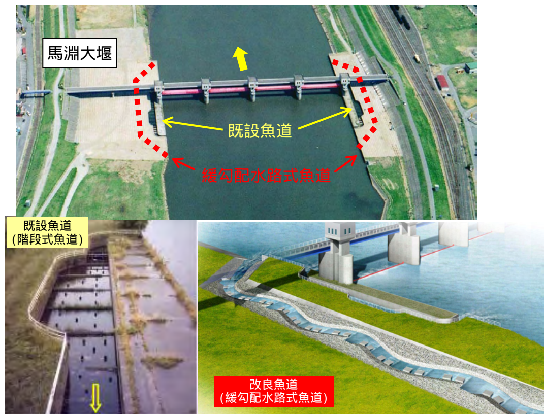
図 5.13 馬淵大堰の魚道の改良イメージ
