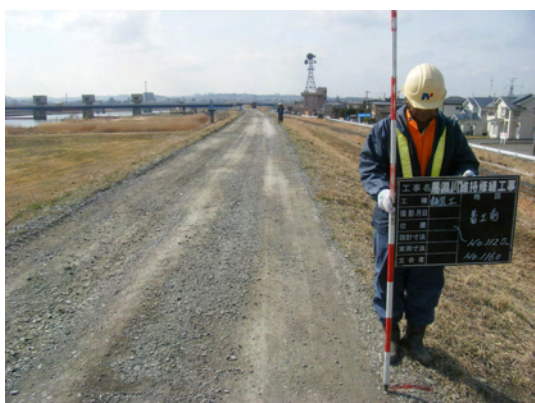
堤防天端の舗装（舗装前）
