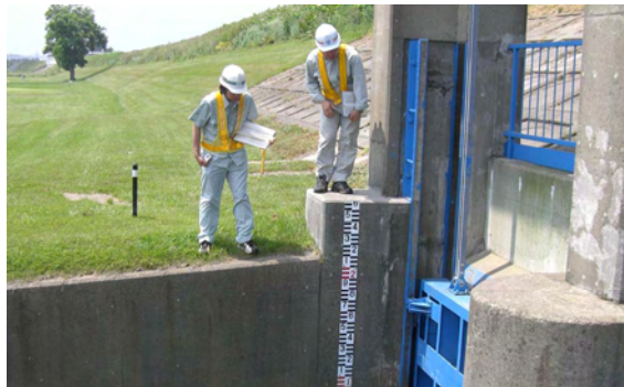
樋門・樋管の点検状況
