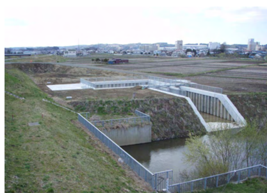
浅水川排水ピット
