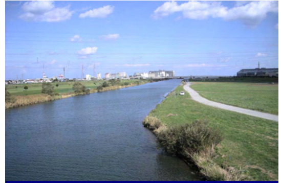
整備された高水敷の間をゆったりと流れる
