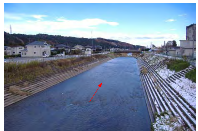
整備後（渡の葉橋～滝谷橋付近）
