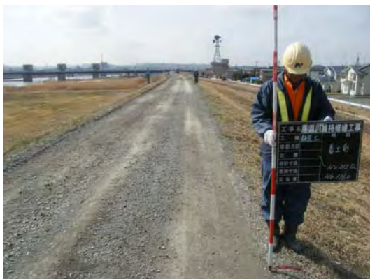
堤防天端の舗装（舗装前）
