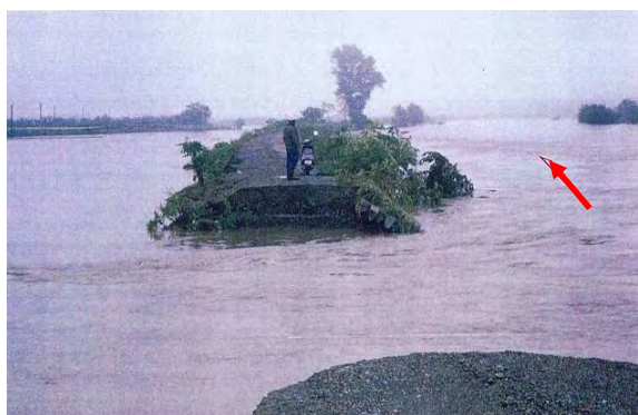
平成 2 年 9 月洪水 三戸郡南部町門虎渡地区 左岸堤防の決壊状況
