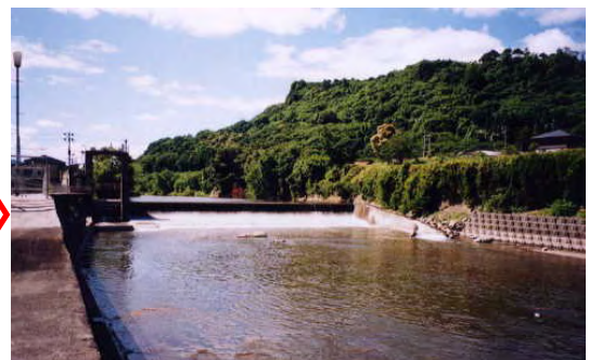
舌崎発電所 取水堰下流地点（改善後）
