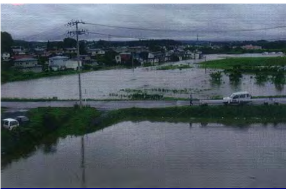
平成 14 年 6 月洪水 大川原地区（八戸市）の浸水状況
