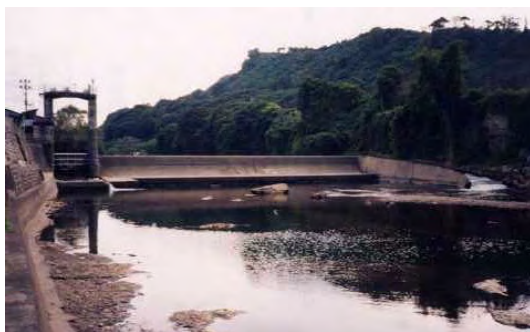
舌崎発電所 取水堰下流地点（改善前）
