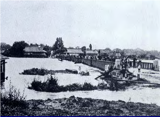
昭和 15 年 9 月洪水 大橋付近の様子
