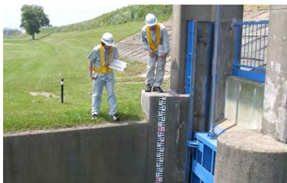
樋門・樋管の点検状況
