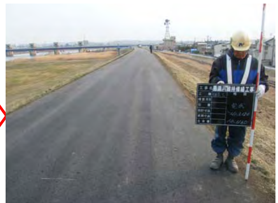
堤防天端の舗装（舗装後）
