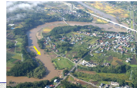
平成 16 年洪水 狭窄部の状況
