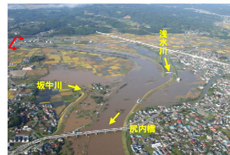
平成 16 年洪水 下流部（直轄区間）のはん濫状況
