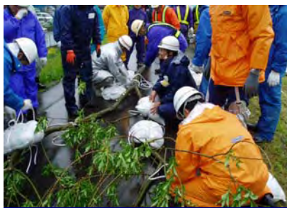
水防工法訓練（木流し工法）
