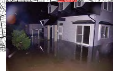
浅水川の内水はん濫による被害状況
