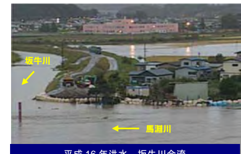
平成 16 年洪水 坂牛川合流 土嚢を並べて水が堤防を越えるのを防いでいる
