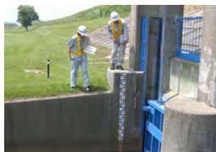
樋門・樋管の点検状況
