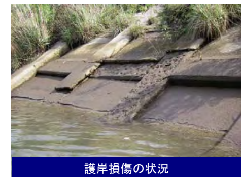
降雨による堤防法面の崩壊
