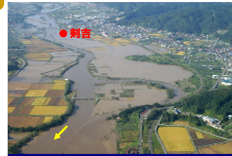
平成 16 年洪水 狭窄部上流のはん濫状況
