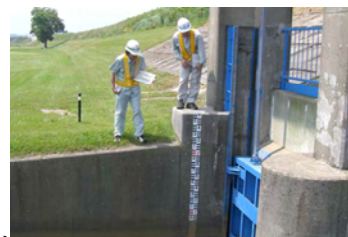
樋門・樋管の点検
