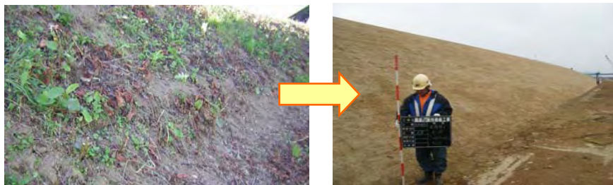
堤防裸地化による堤防法面の補修
