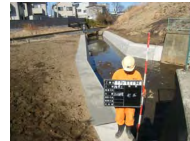
護岸の修繕状況
