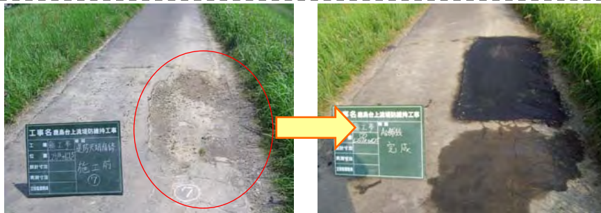
堤防天端損傷による補修
