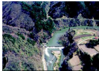
【小中島発電所取水口】 ・昭和31年～ ・最大取水量29.0m 3 /s
