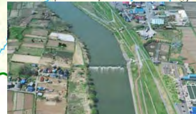
【八戸工業用水取水口】 ・最大取水量4.34m 3 /s
