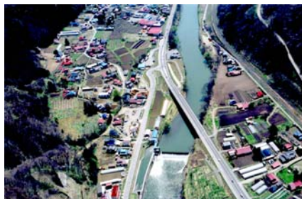
【舌崎発電所取水口】 ・大正12年～ ・最大取水量16.66m 3 /s
