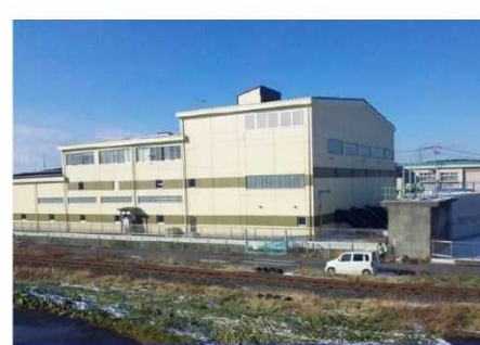
下長雨水ポンプ場 (管理者: 八戸市)
