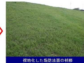
裸地化した堤防法面の補修
