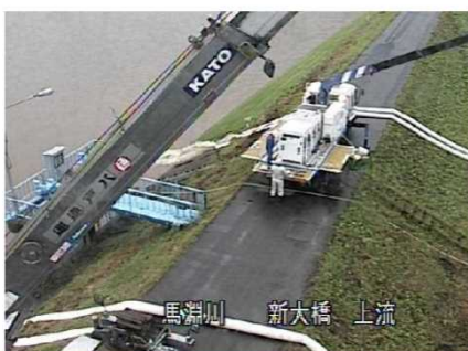
八戸市所有の排水ポンプ車による内水排除状況
