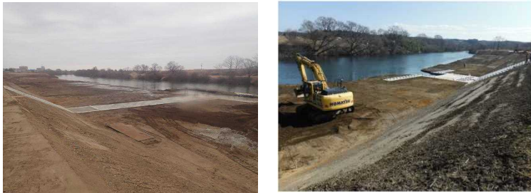
一日市地区河道掘削工事
