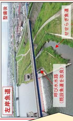
魚がのぼりやすい「せせらぎ」を流しきり崩壊します
