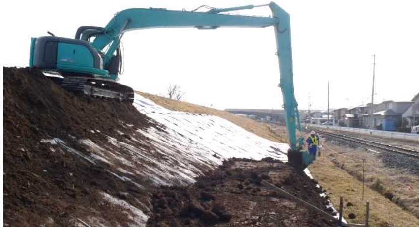
発生土砂は堤防の側帯盛土（馬淵川左岸1.8km付近）材料に利用（H30.3）
