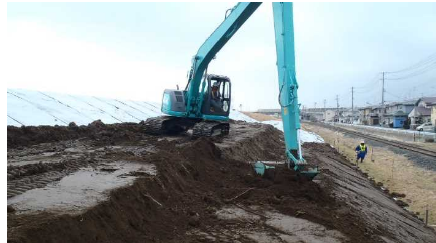
発生土砂は堤防の側帯盛土（馬淵川左岸1.8km付近）材料に利用（H30.3）
