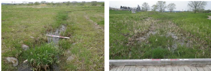
水辺の楽校せせらぎ水路維持管理状況 (H30. 4. 27)
