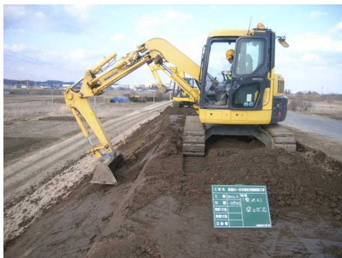
掘削土砂を側帯盛土として利用
