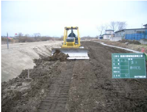
発生土砂は堤防の側帯盛土材料に利用
