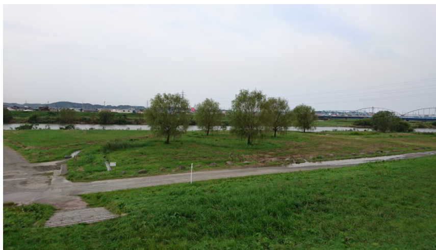
せせらぎ水路周辺の維持管理状況
