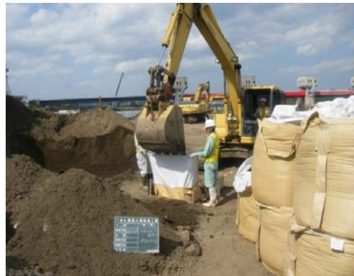
発生土砂は仮設工事の土嚢に利用
