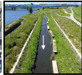
▲新たに設置したせせらぎ式魚道
