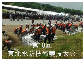
水防工法訓練 (釜段工)
