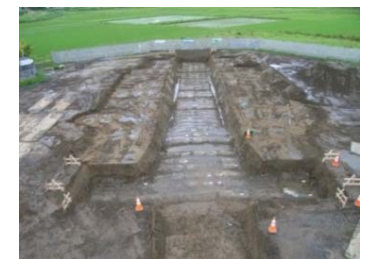
地盤改良完了
