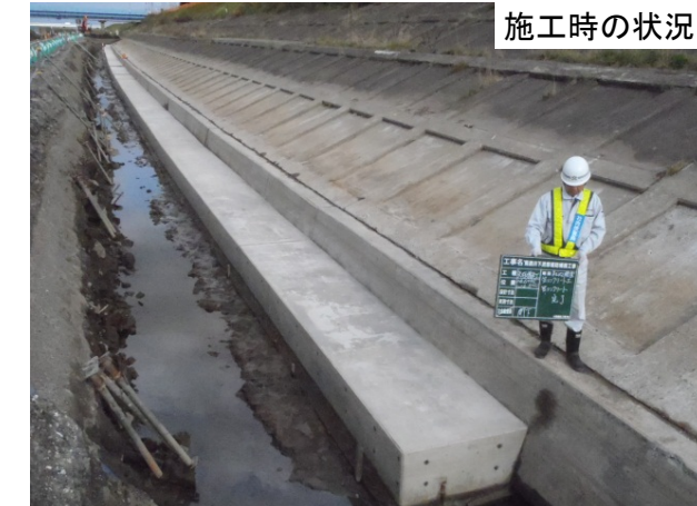
遮水矢板設置状況
