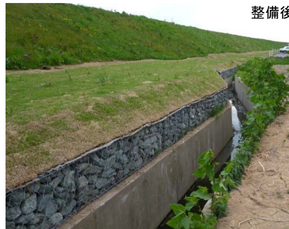
ドレーン工設置状況
