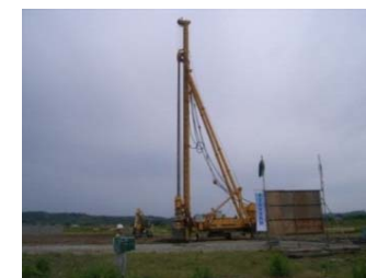
地盤改良状況 DJM工法(粉体噴射攪拌工法)
