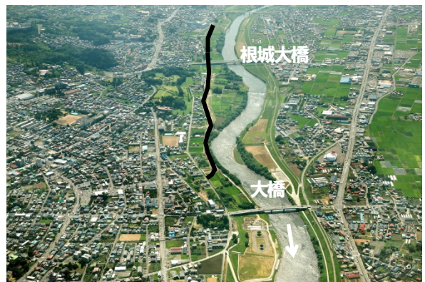
根城大橋～大橋区間
