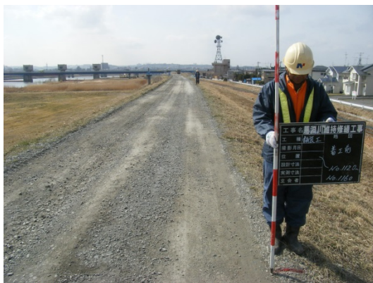
舗装前の状況
