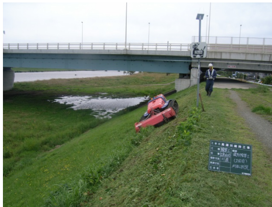
堤防除草作業の様子
