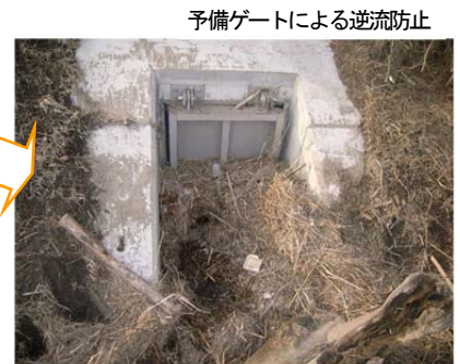
予備ゲート整備による津波逆流被害防止の状況（浜名谷地排水樋管）
