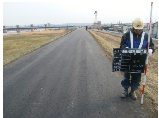
舗装後の状況
