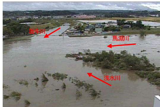
馬淵川・浅水川・坂牛川合流地点の状況
