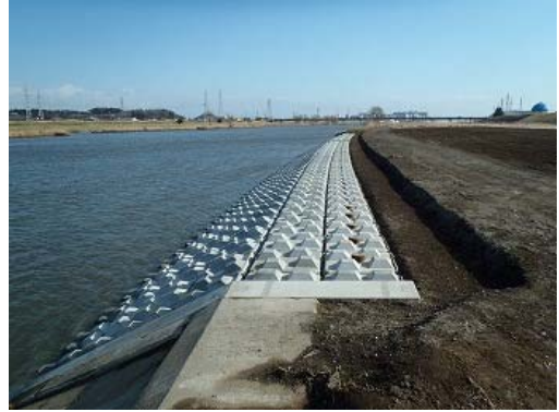
損傷箇所の補修状況
