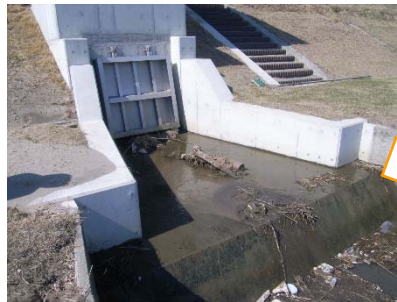
予備ゲートの整備
