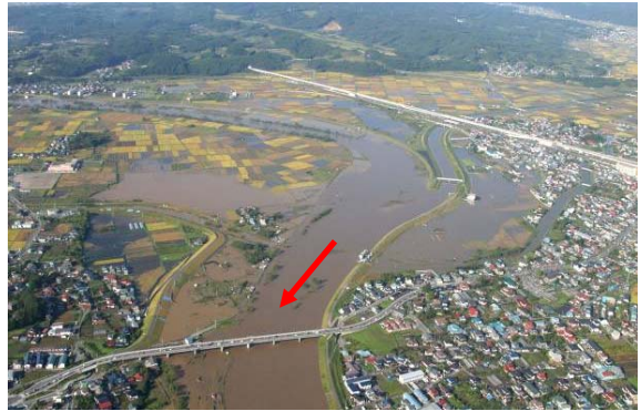
八幡・尻内地区(八戸市)の浸水状況
