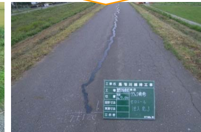
クラック補修の状況
