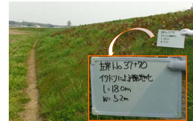
堤防の目視点検状況
