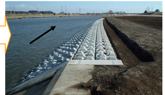
損傷箇所の補修状況(H27年3月)
