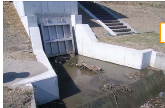
予備ゲートの整備
