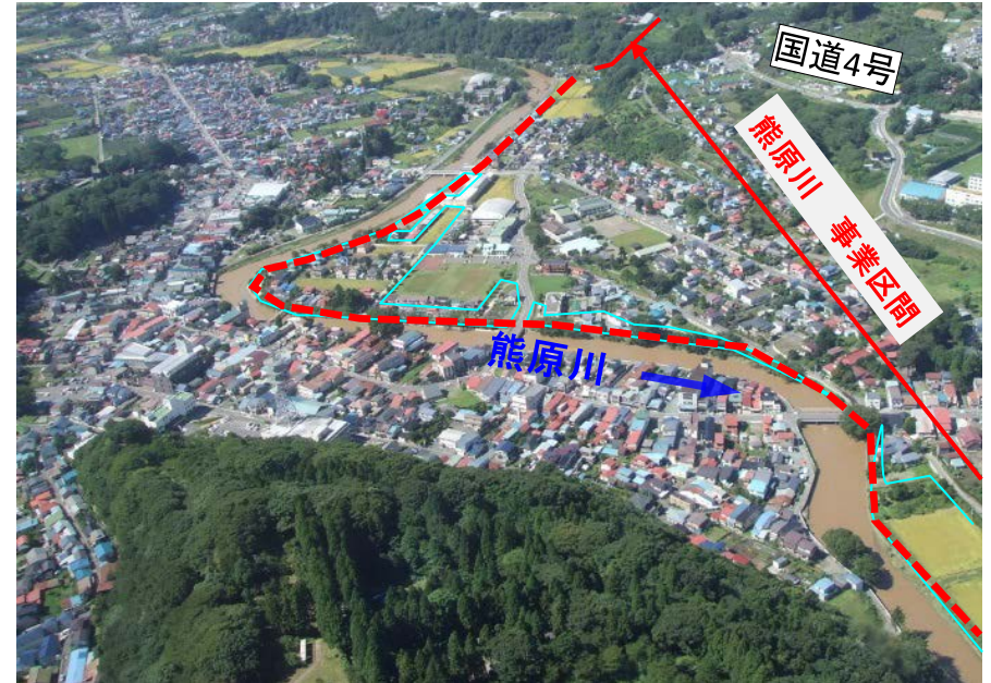
熊原川（関根川原地区）
