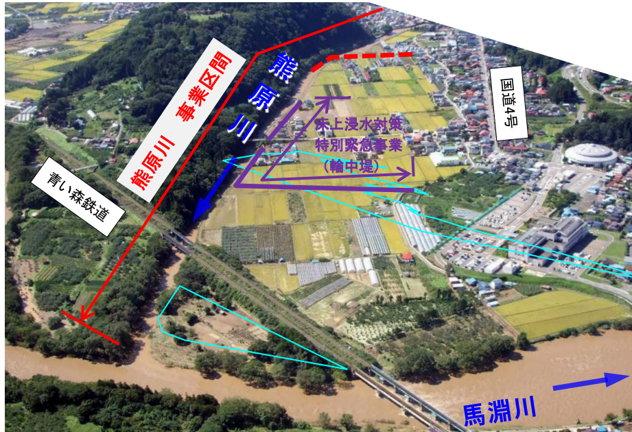
熊原川（橋ノ下地区）
